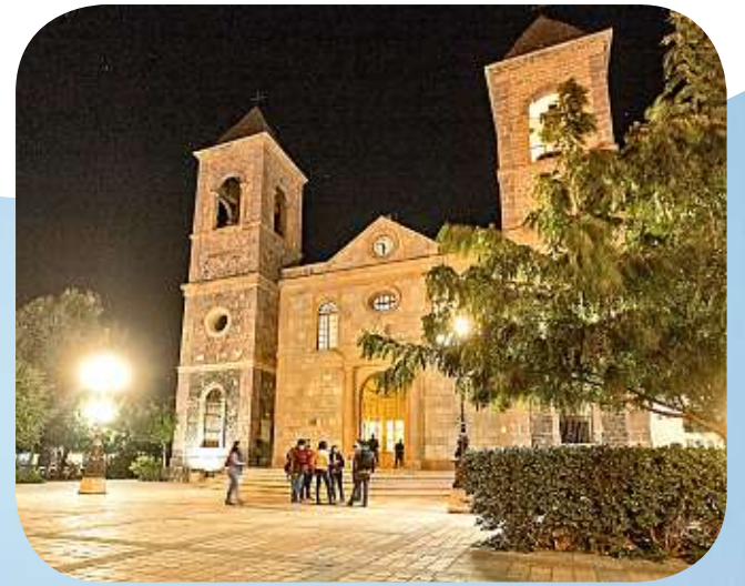
■En octubre de 1861 se colocó la primera piedra de la Catedral.
