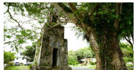
Bell Tower 馬利索鐘塔
